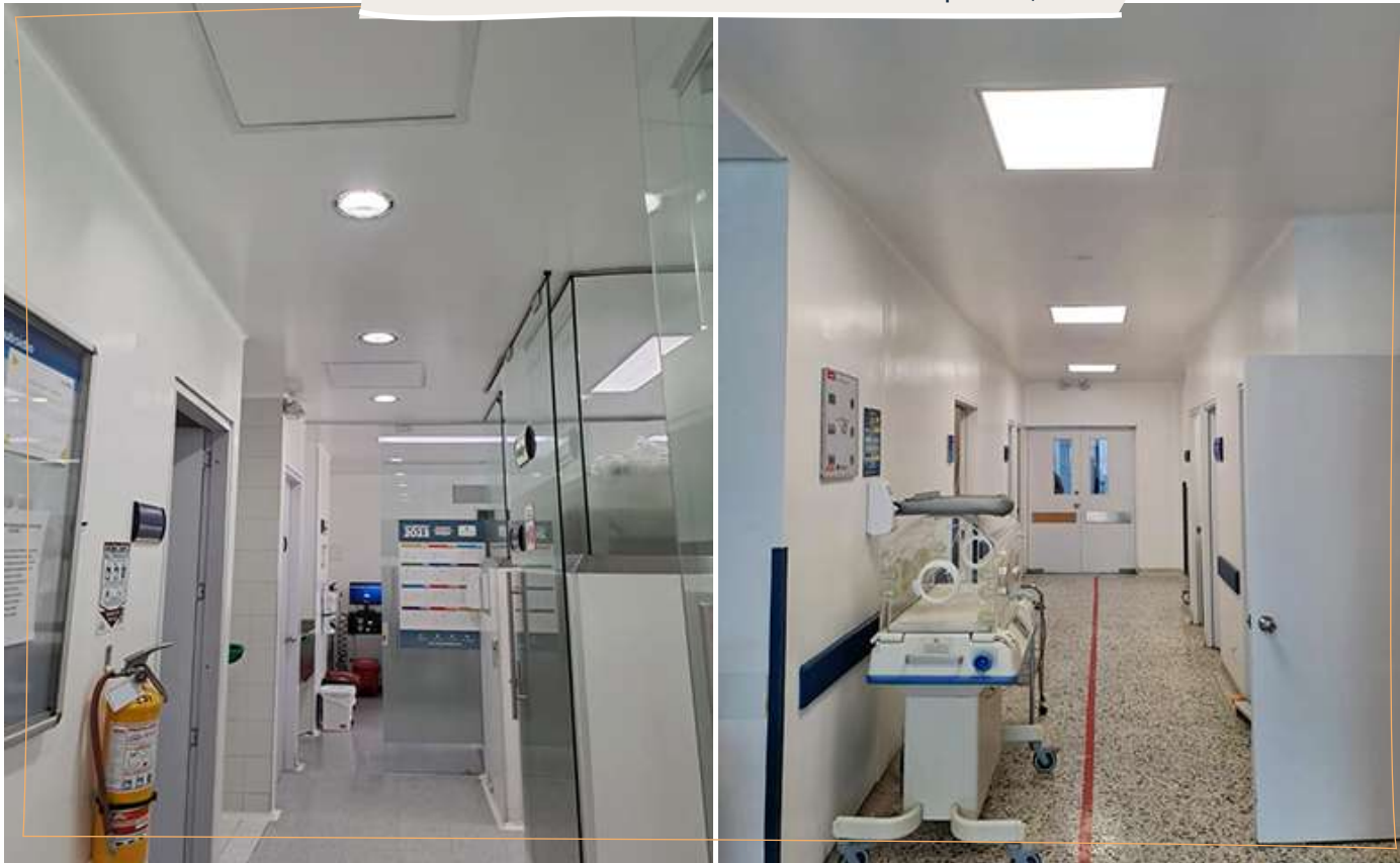
Proceso de sustitución de iluminación convencional por LED, fase II.
