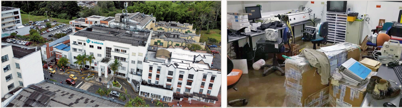
Localización de la clínica (izq); daños por inundación en 2013 (der).
