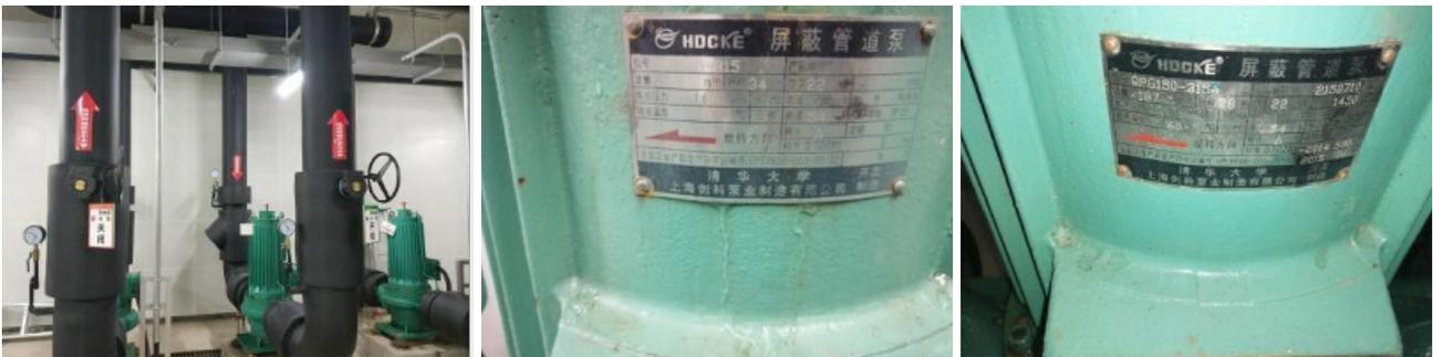
Fotografías y placas de identificación de las bombas de agua de circulación
