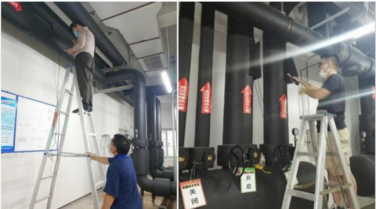
Registro en campo del caudal de agua de suministro y de retorno en el lado del aire acondicionado y en el lado geotérmico
