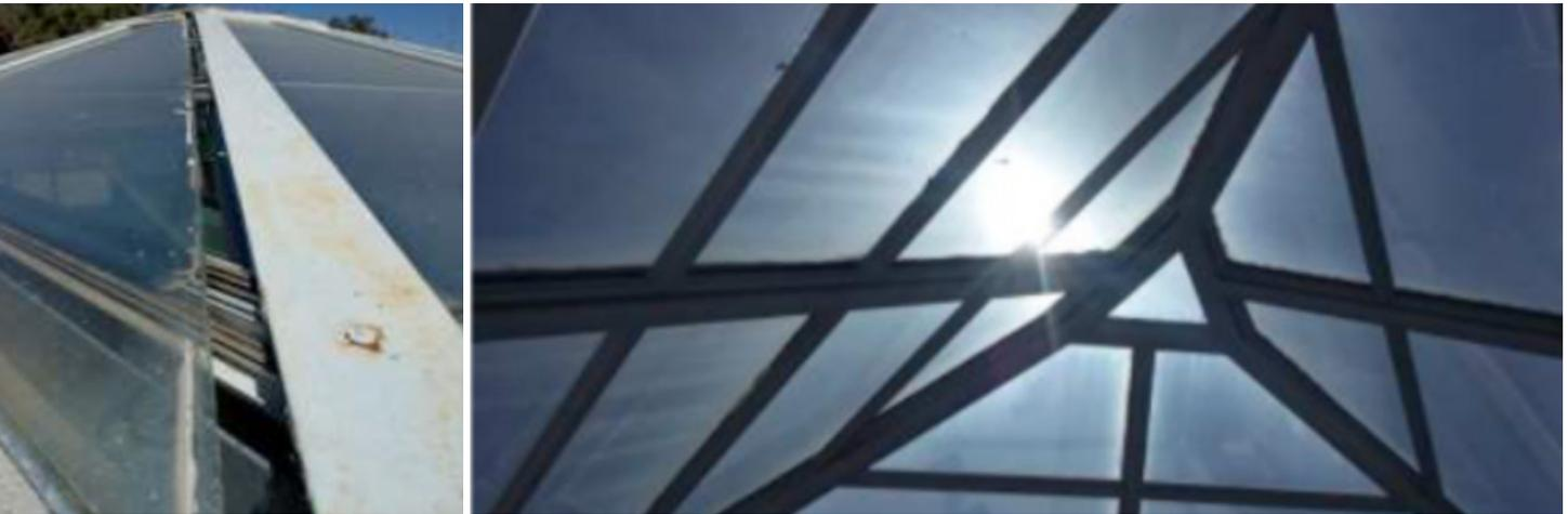
Infiltración de aire y entrada de luz a través de las lucarnas
