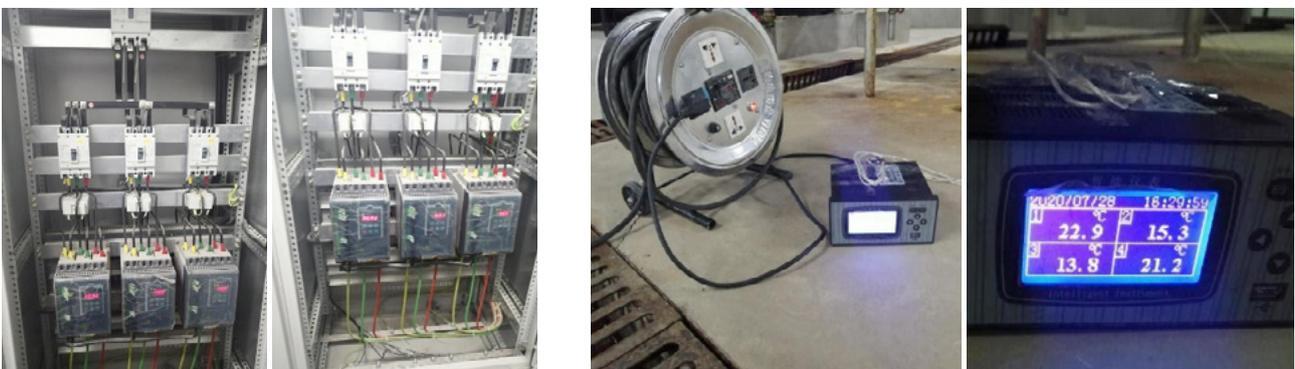
Frecuencia operativa de la bomba con variador de frecuencia en el lado del aire acondicionado y en el lado geotérmico
