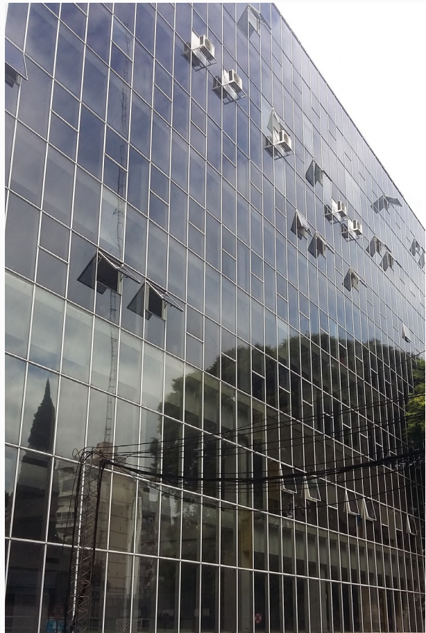
Fachada norte del CEMAR, Rosario
