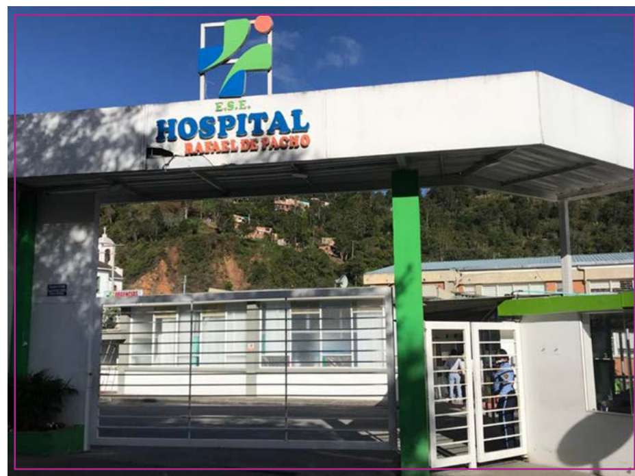
Fachada E.S.E. Hospital San Rafael de Pacho
