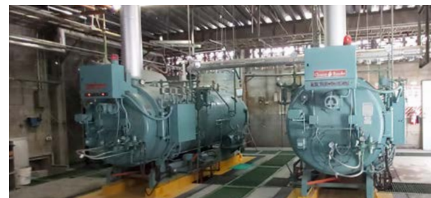
Sistemas de calderas reparadas
