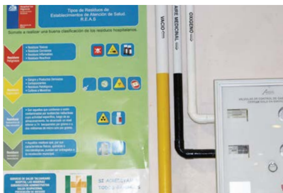
Cartel informativo de segregación de residuos en el área de Urgencias
