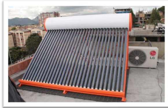
Hospital de Suba: Calentador de agua solar
