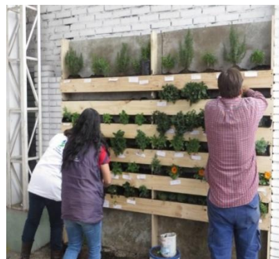
Muro Verde E.S.E. San Cristóbal
