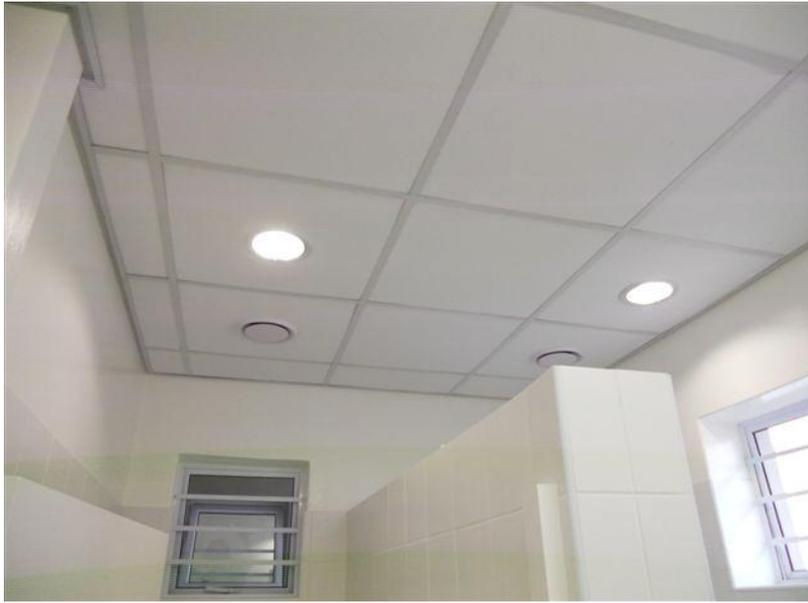
**Luz orientada hacia el lugar de tareas usando tubos fluorescentes T5, mini lámparas CFL y LED – junto con paredes de colores claros**
