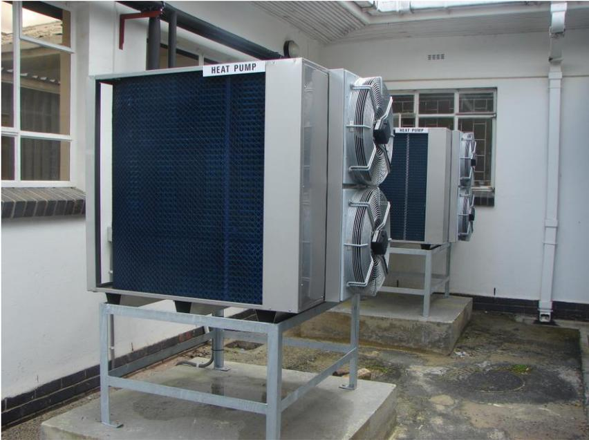
**Bombas de calor para agua caliente y un eficiente calentamiento eléctrico en el punto de uso para la cocina y autoclaves**
