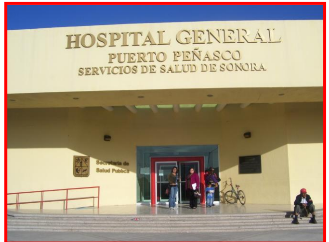
Frente del Hospital General de Puerto Peñasco
